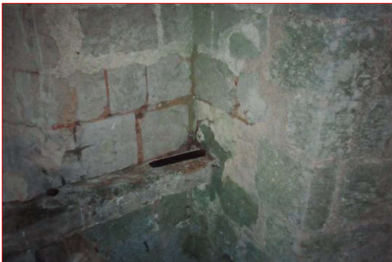
Archives municipales, En haut : structure de la cloche 2 En bas : poutre transversale de soutien avec emprise dans la maçonnerie
