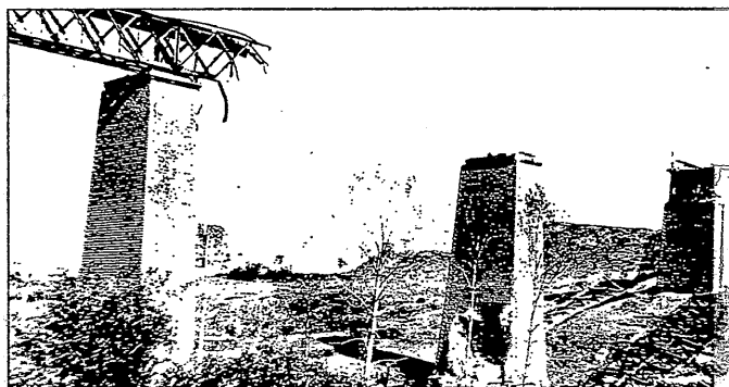
1. Le viaduc de Thouars après les bombardements.
