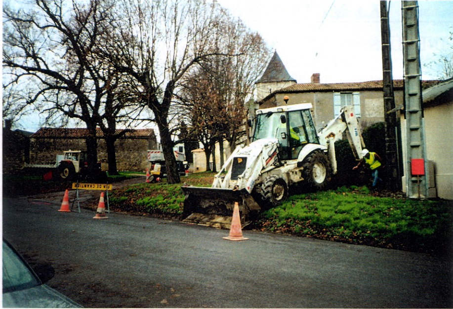
Enfouissement d'une ligne moyenne tension (Nov. 2000) pour remplacer la ligne endommagée lors de la tempête.
