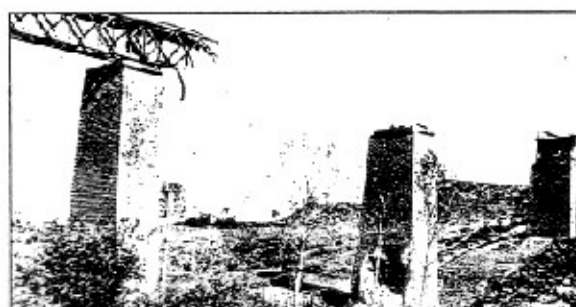
1. Le viaduc de Thouars après les bombardements.
